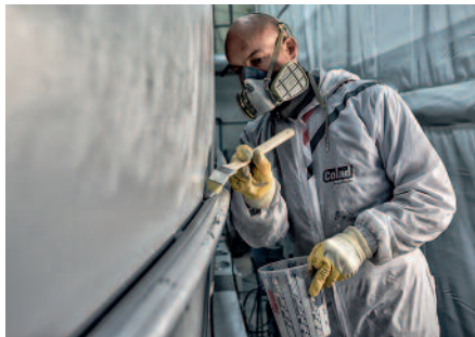
Minutiös die Maler- und Spachtelarbeiten bis in die kleinsten Ritzen.
